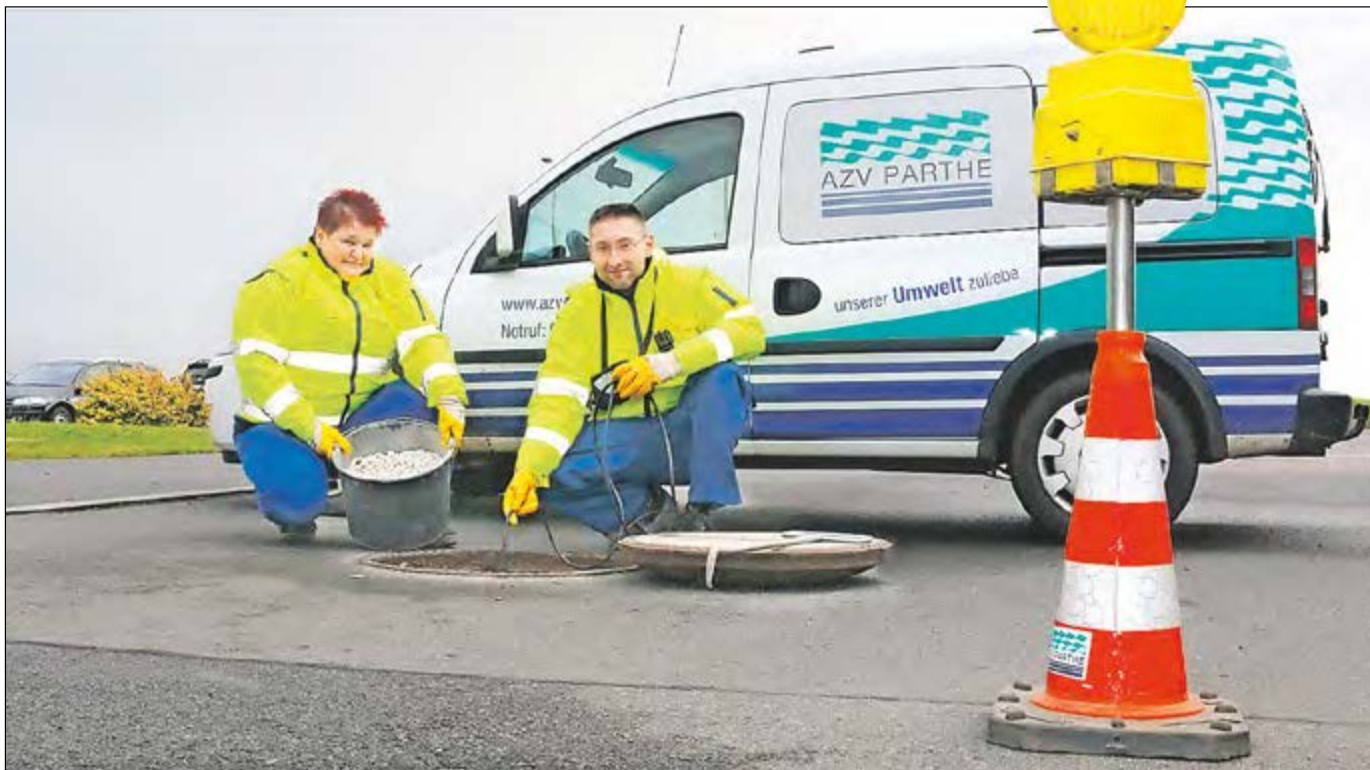
AZV-Mitarbeiter beim Einsatz am Schmutzwasserkanal: Sabine Lantzsch zeigt einen Eimer mit geruchsbindendem Granulat, während Paul Dittrich die Gaskonzentration im Kanal misst.
